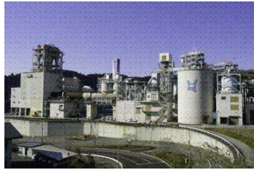
写真 2-5 エコセメント化施設
