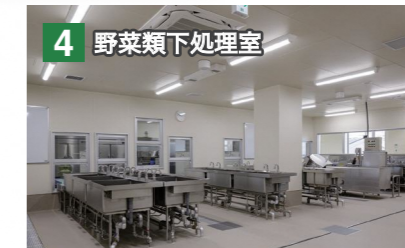
4 野菜類下処理室 除去が難しいとされる虫や毛髪に異物除去効果のある洗浄機を導入。シンク類はフットバルブ方式で、手で作業しながら足操作で給水・給湯をコントロールできます。
