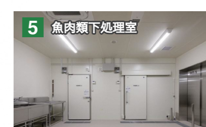
5 魚肉類下処理室 移動式作業台は、下味・粉付けなどの下処理作業に合わせてレイアウト可能。下処理した魚肉類は、加熱時刻までプレハブ冷蔵庫や冷凍庫で一時的に保管します。
