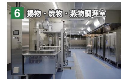
6 揚物・焼物・蒸物調理室 連続フライヤーは集中排気で作業しやすく、オイルミストキャッチャーが油分や臭いを除去。コンビオープンには加熱前後の動線を一方にするパススルー方式を採用。
