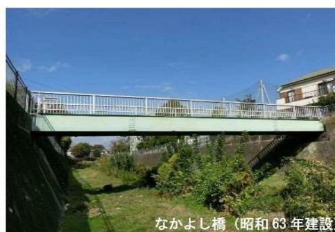
写真 2.2 約 20 年後に 50 年を経過する橋梁
