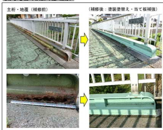
なかよし橋 (令和3年度 補修)
