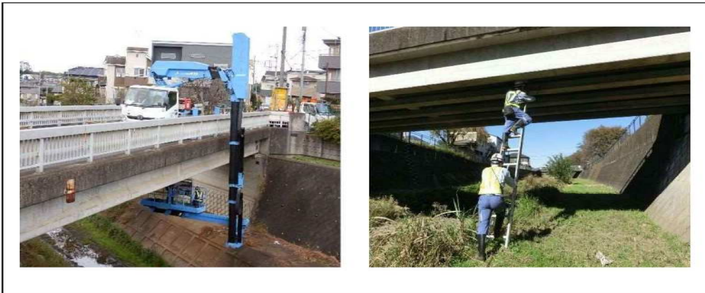
写真 2.3 定期点検状況
