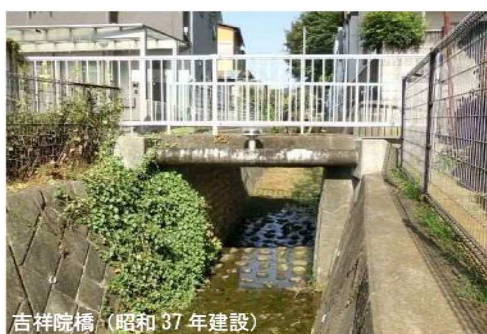
写真 2.1 建設後 50 年を超える橋梁
