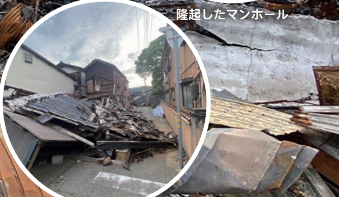
倒壊した家屋
