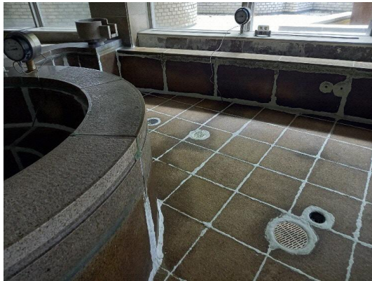
【例：洋風風呂応急対応状況(水中ボンドによる漏水対応)】
