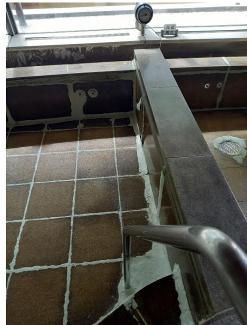
【例：洋風風呂応急対応状況(水中ボンドによる漏水対応)】
