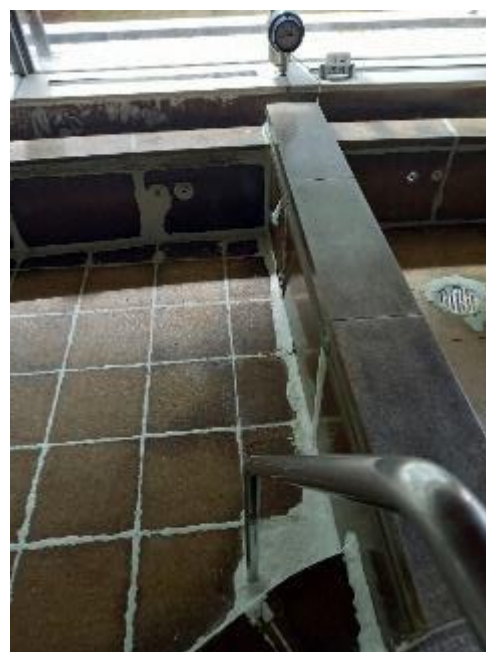
【例：洋風風呂応急対応状況（水中ボンドによる漏水対応）】
