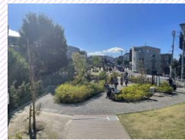
透水性舗装の通路及び雨庭（世田谷区）
