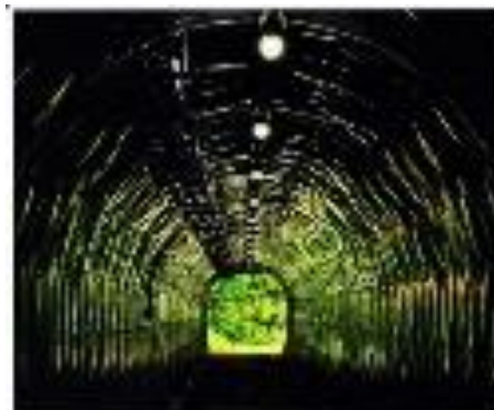
<御岳トンネル>
