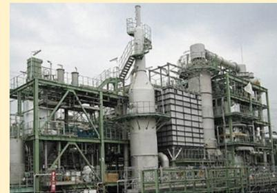
【汚泥ガス化炉】下水汚泥を低酸素状態で蒸し焼きにし、可燃性ガスを発生させ、発電に活用します。蒸し焼きにすることで、温室効果ガスが大幅に削減できます。
