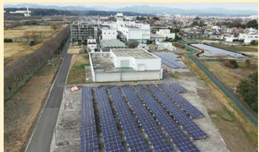
【太陽光(ソーラー)発電】地球温暖化対策として、発電時にCO<sub>2</sub>を発生させない太陽光発電設備を設置し、センターが使用する電力の一部を補っています。
