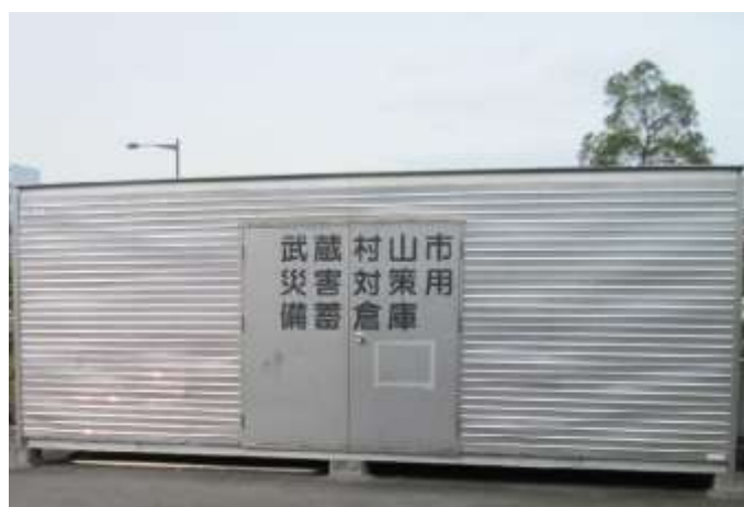
<災害対策用備蓄倉庫>
