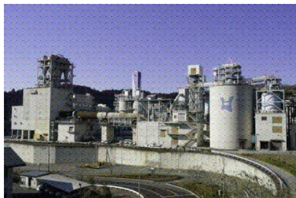
写真 2-6 エコセメント化施設
