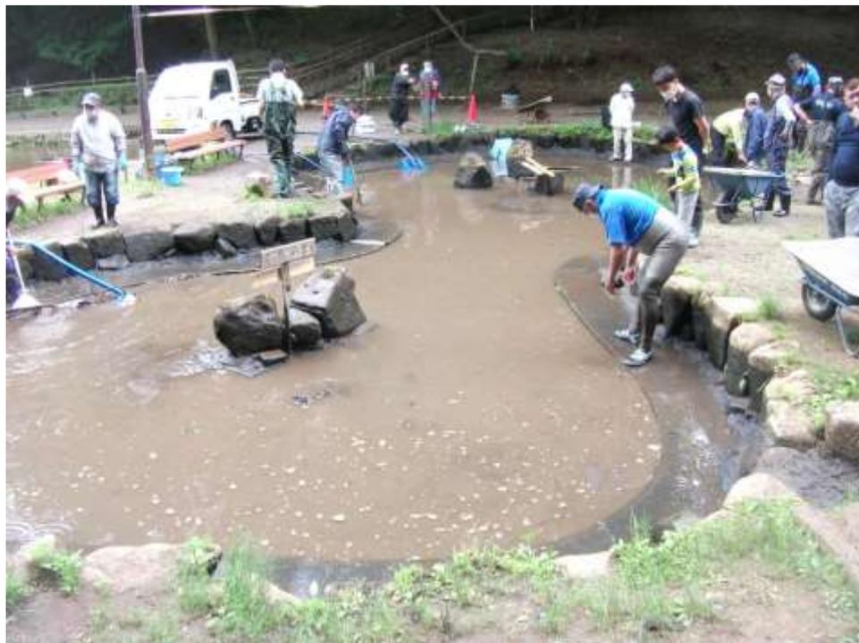
水がだいぶ抜けてきたところで、池底の泥をさらいます。泥は重いので作業は大変。カゴにいれた泥を、ふたりがかりで持ち上げます。
