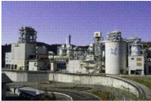
写真 2－5 エコセメント化施設
