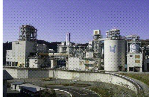
写真 2-5 エコセメント化施設
