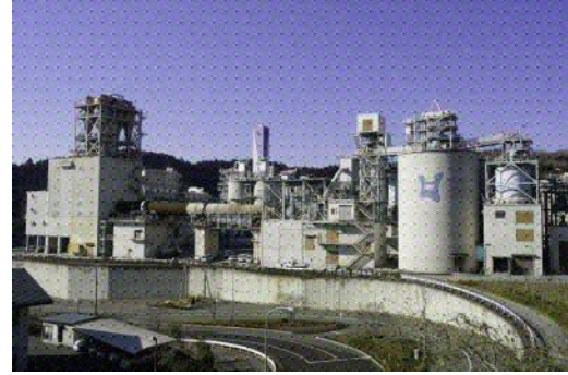
写真 2-5 エコセメント化施設
