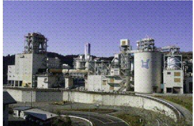
写真 2-6 エコセメント化施設
