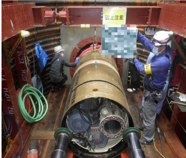
掘進機の設置
