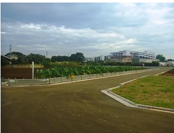
↓ ③ 区画道路築造第24号工事 （幅員5~6m）
