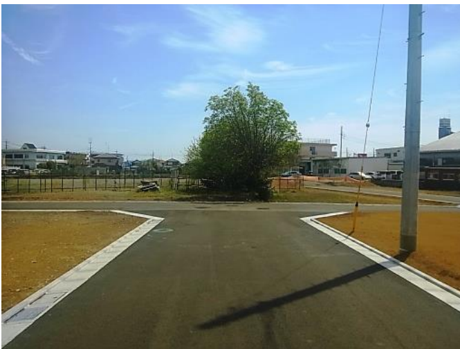
↓ ① 区画道路築造第23号工事（幅員5~6m）
