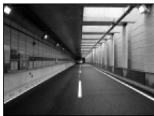
図-3 半地下式トンネル
