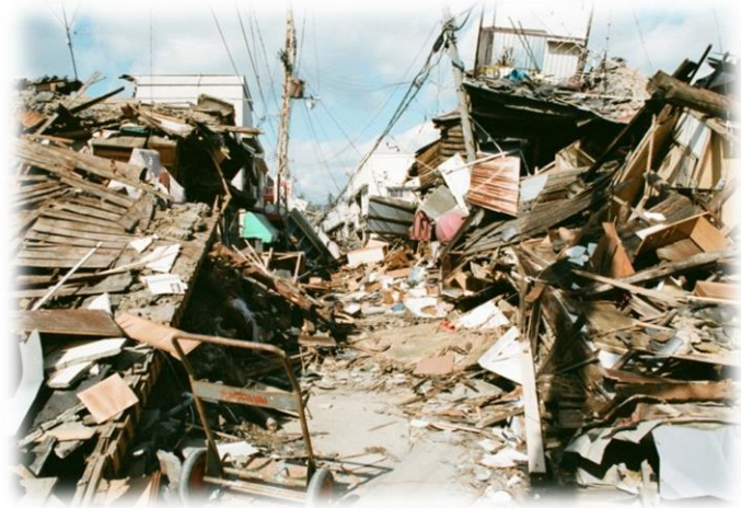
図1-2 大規模地震時の道路閉塞（阪神・淡路大震災時の状況）
