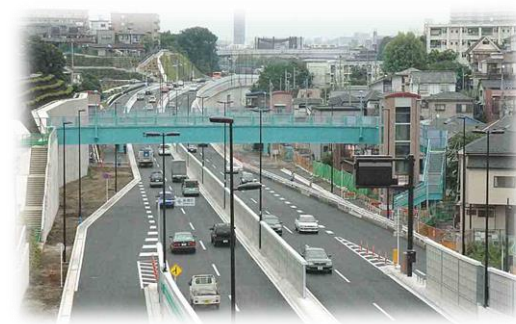
環状 8 号線〔平成 18 年開通〕 （板橋区若木）
